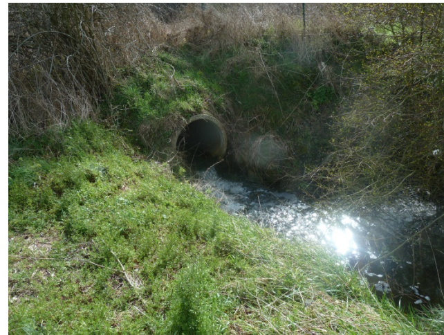
Débouché du ru de Chèvreloup après passage sous l'A12 au niveau du futur rejet
